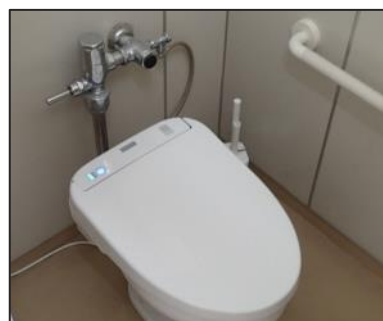
トイレ・洗面所
